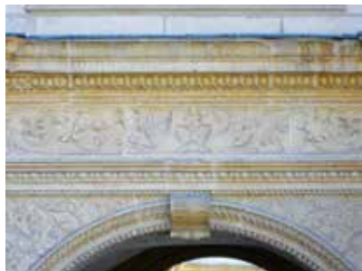
Détail des bas-reliefs du portail de la cour basse de l'Hôtel Lallemant : grottesques, ornements végétaux et géométriques...
