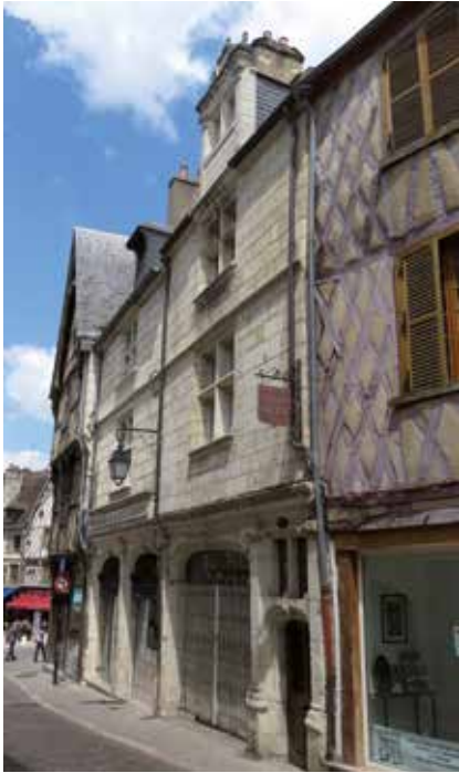
Aux 3 et 5 rue Bourbonnoux, les baies du rez-de-chaussée sont encadrées de fins pilastres ioniques.
