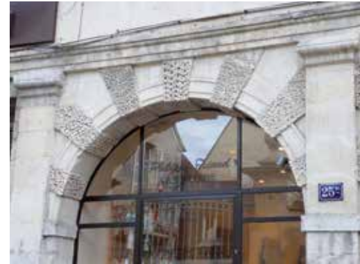
Maison Pastoureau, rue d'Auron - Détail des bossages un-sur-deux.
